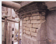
洗石子牆面內部的紅磚構造。(1998年整修時攝) The brick structure beneath the wall coated with mini pebbles
