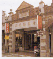
李記興源的牌樓立面。 Façade of the arcade
