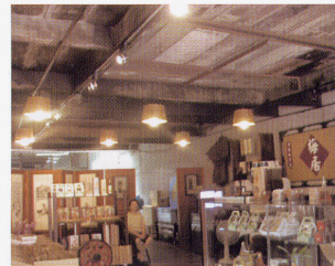
店口可見天花板的木結構。 Structure of the ceiling still visible
