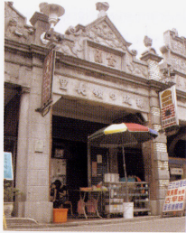
金源的牌樓立面。 Façade of the arcade of Jin-yuan
